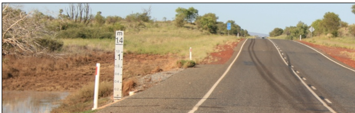
Indicateur du niveau d'eau pouvant atteindre la route
